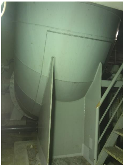
写真① 水素酸素ガス切断前 復水管
