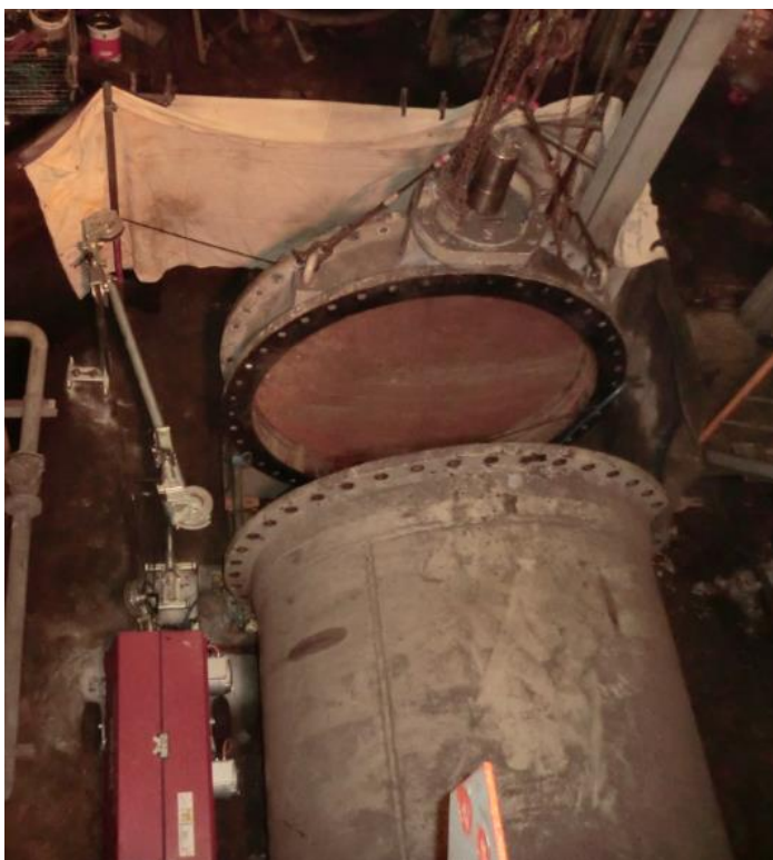
ダイヤモンドワイヤーソー設置
