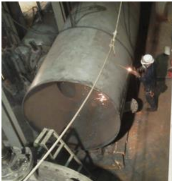
水素酸素ガスによる復水管切断状況
