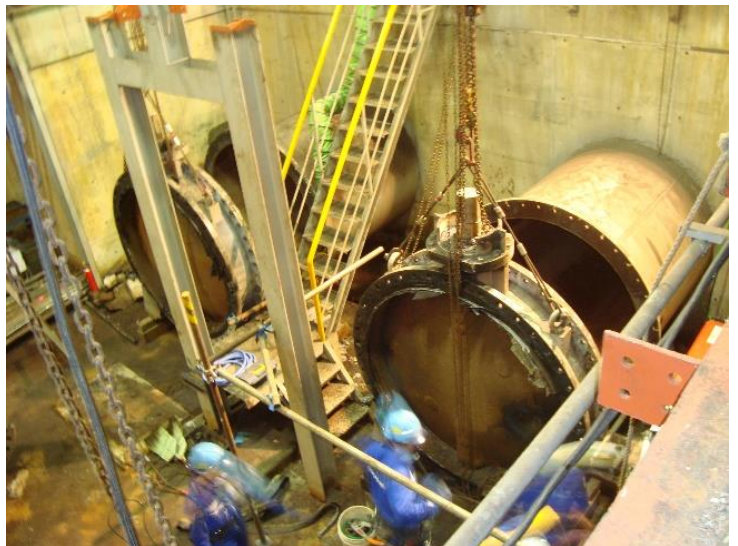
写真② ダイヤモンドワイヤーソー切断撤去前 バタフライ弁全景
